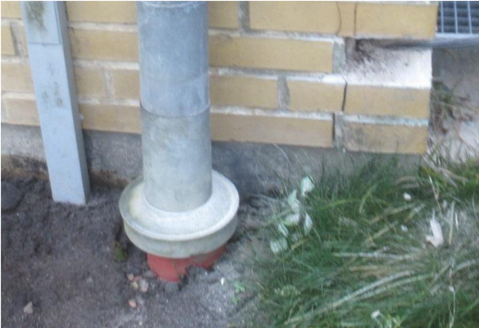
Eksempel på revne i sokkel.
