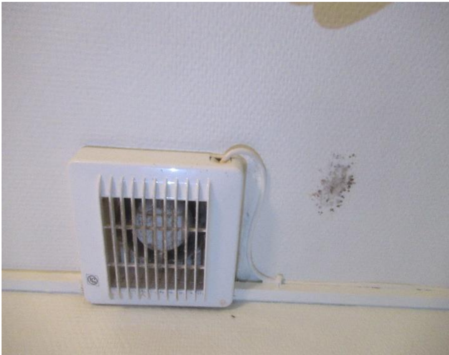
Eksempel på skimmeldannelse på loft i baderum.
