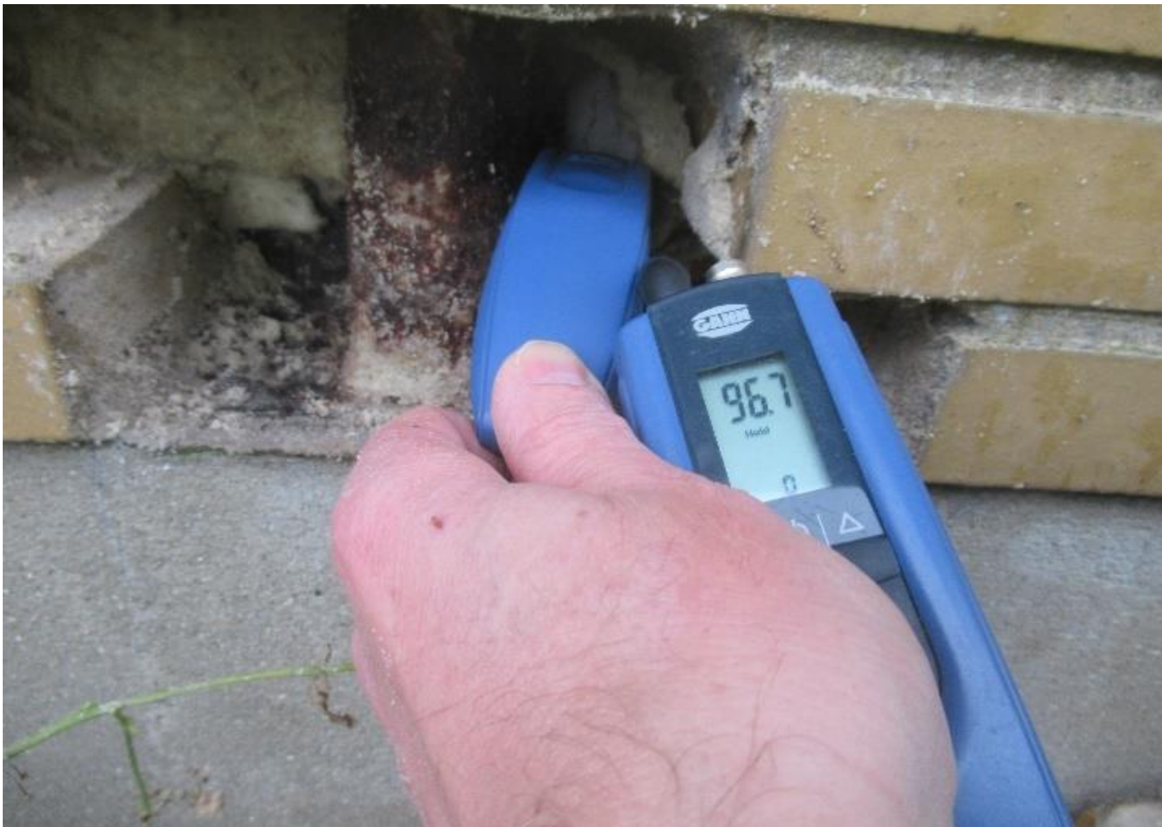
Eksempel på fugtmåling i bagmur.
